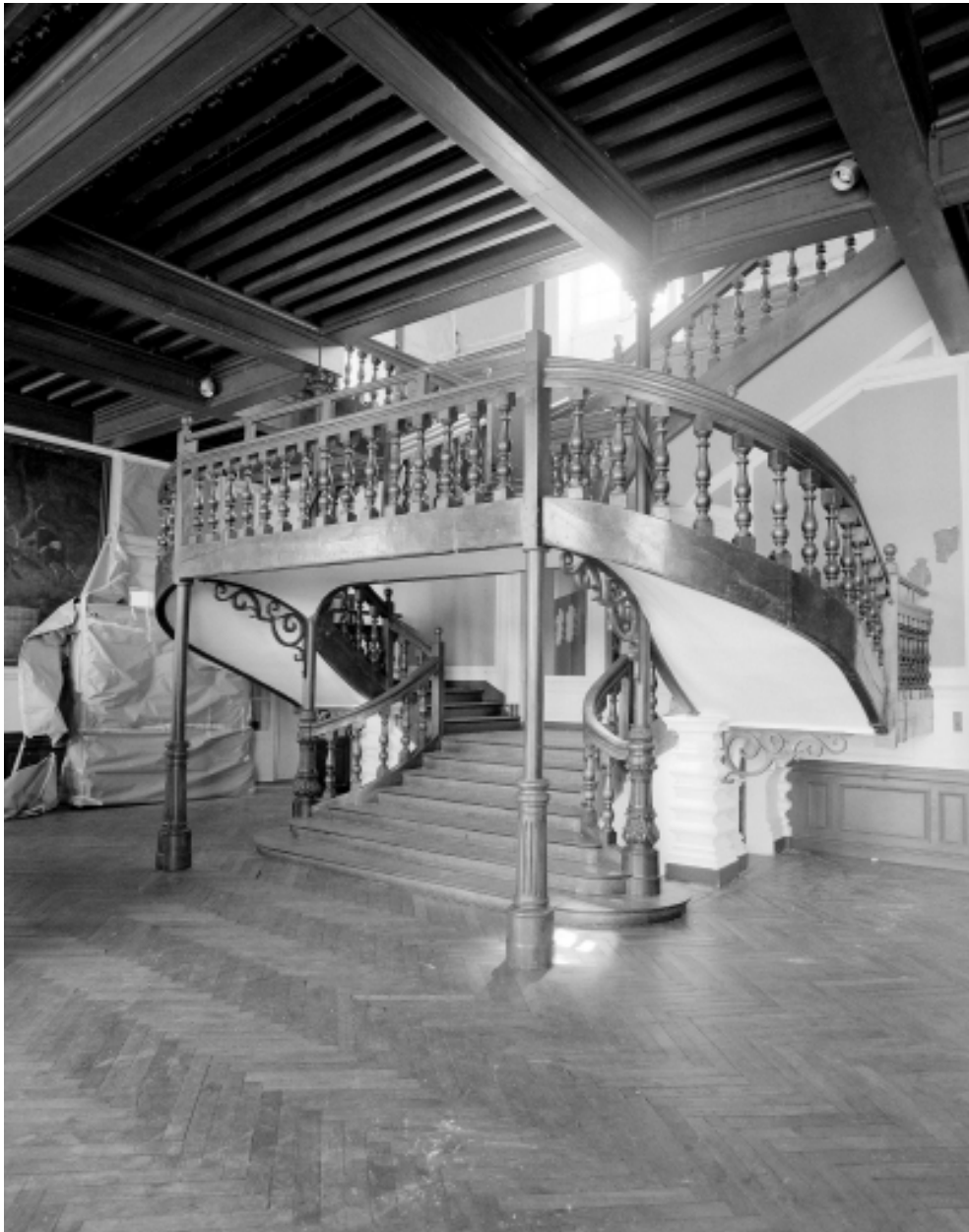
Vue générale de l'escalier central du hall d'entrée.
