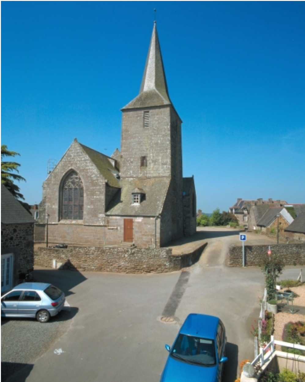
Vue générale est
