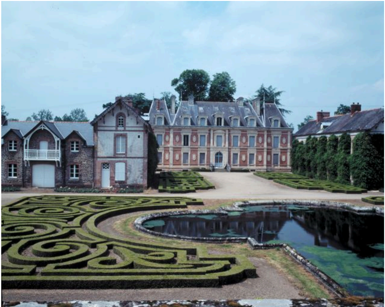
Château et dépendances : vue sud-est
