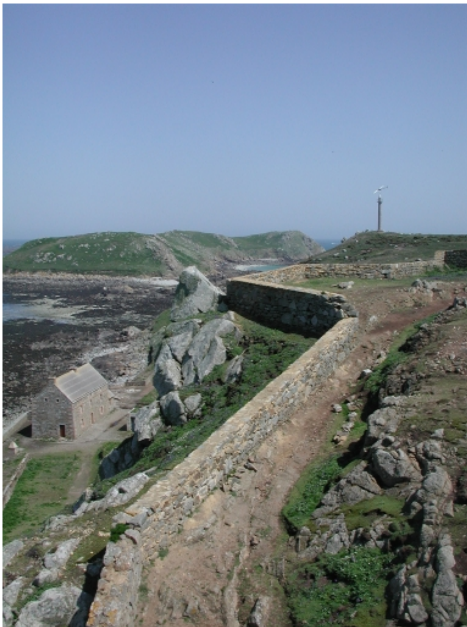
Vue générale des murets défensifs côté nord du chemin de ronde
