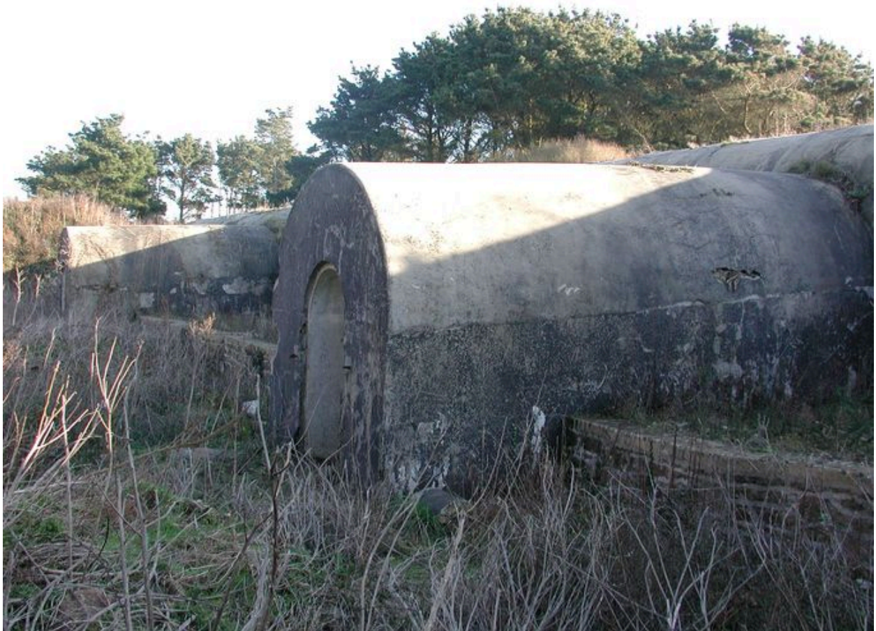
Vue du magasin à munitions (état en 2002)
