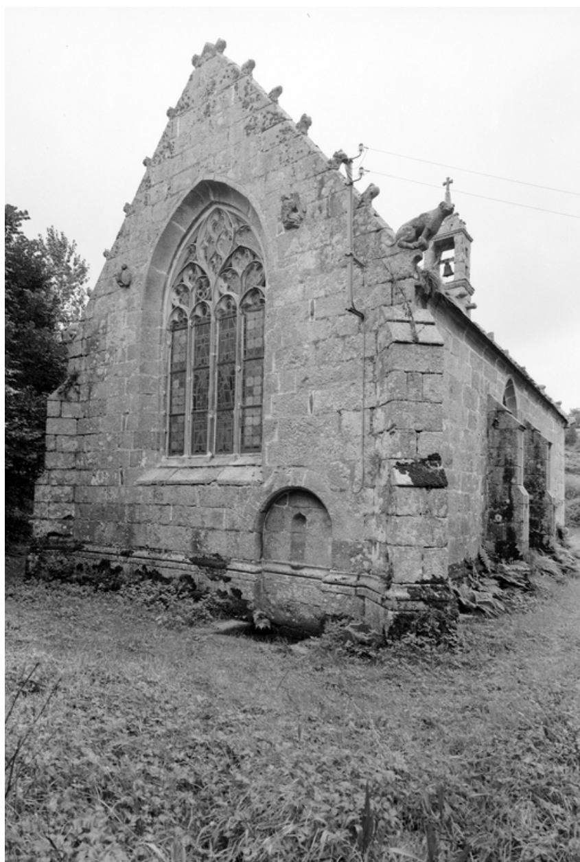
Vue générale de la face est
