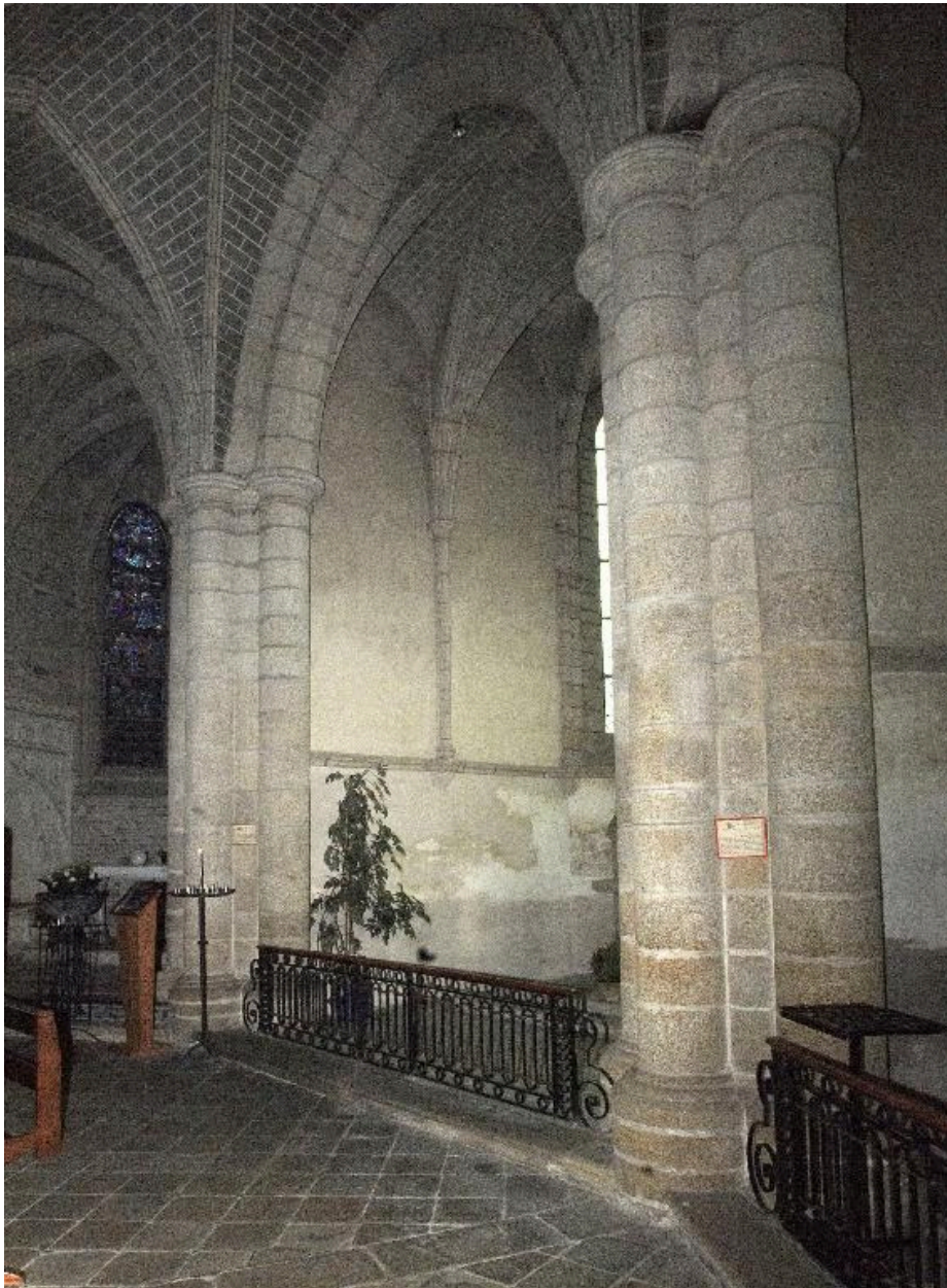
Vue de l'entrée d'une chapelle rayonnante du choeur
