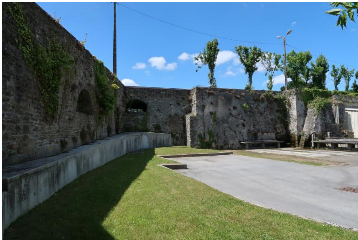
Vue générale de la digue de l'étang (état en 2022)
