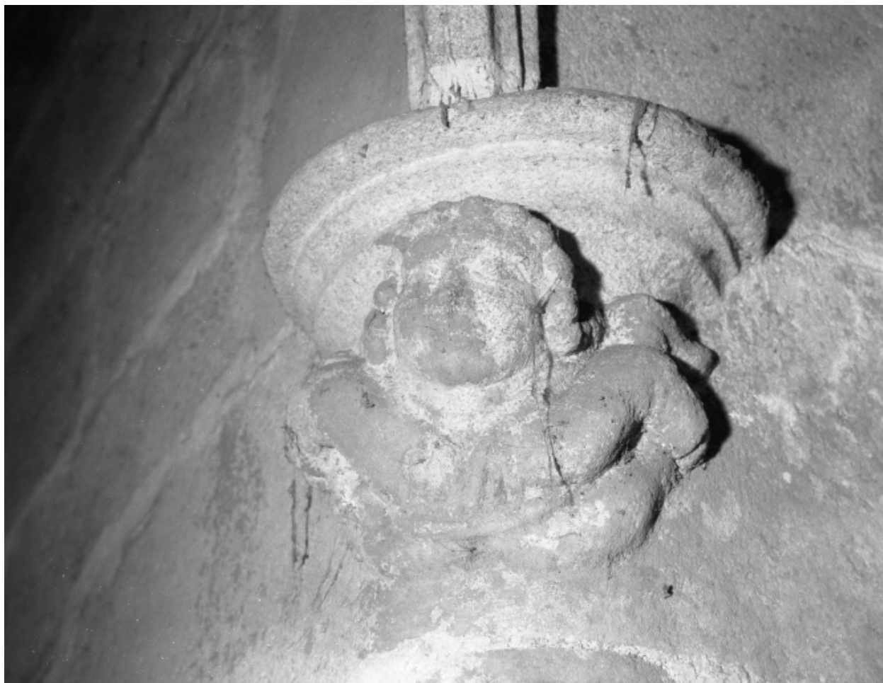
Escalier, 3ème repos du rez-de-chaussée : détail du cul-de-lampe sud ouest
