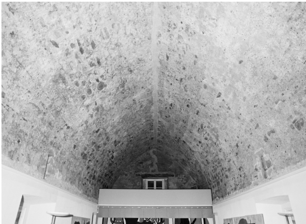
Vue intérieure du magasin à poudre : voûte en arc brisé en moellon (état en 1996)
