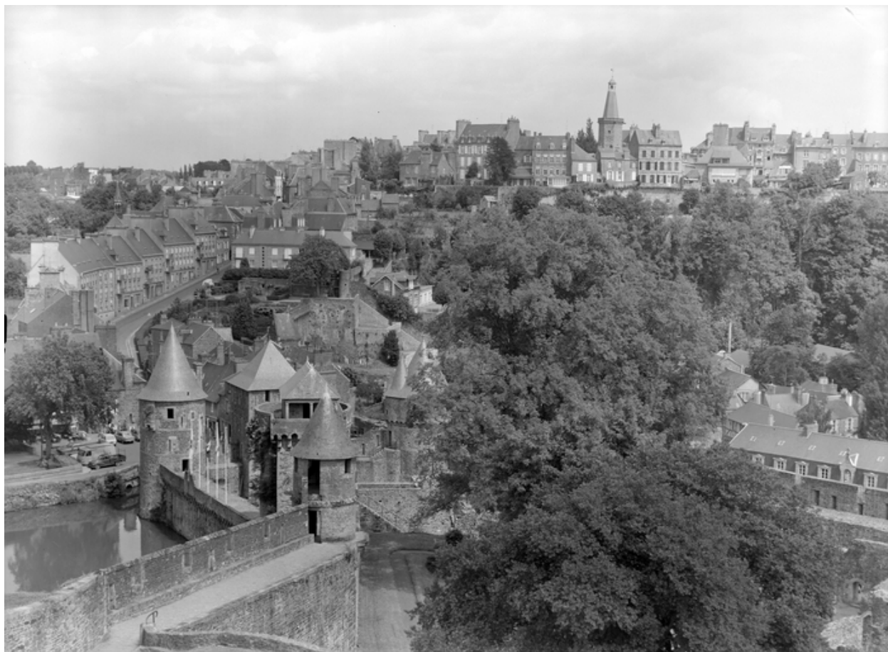
Vue générale prise de la courtine nord.
