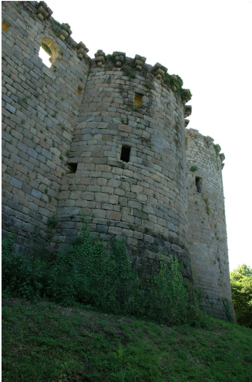
Vue du front est en contre-plongée : tour nord-est
