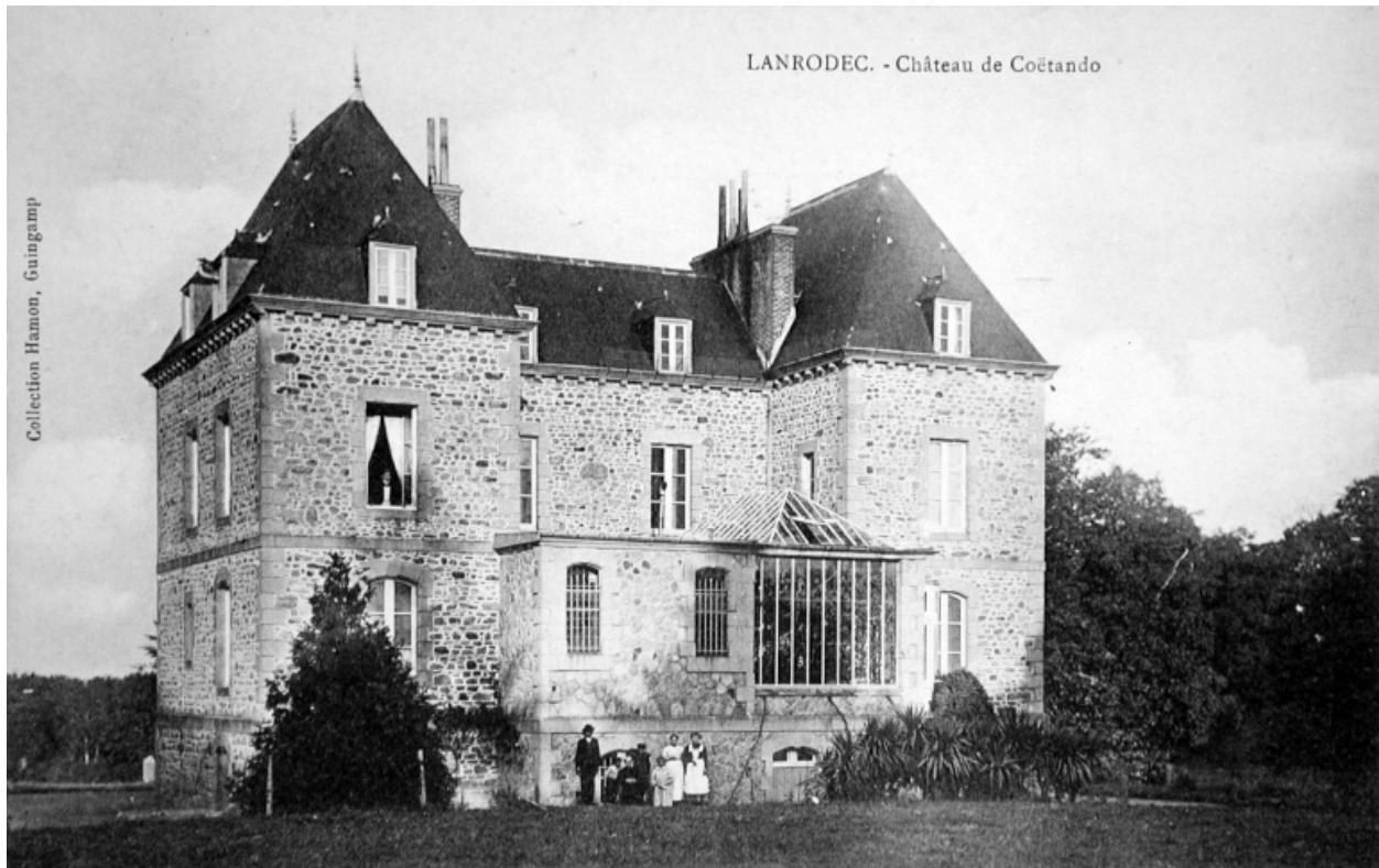
Vue de la façade postérieure
