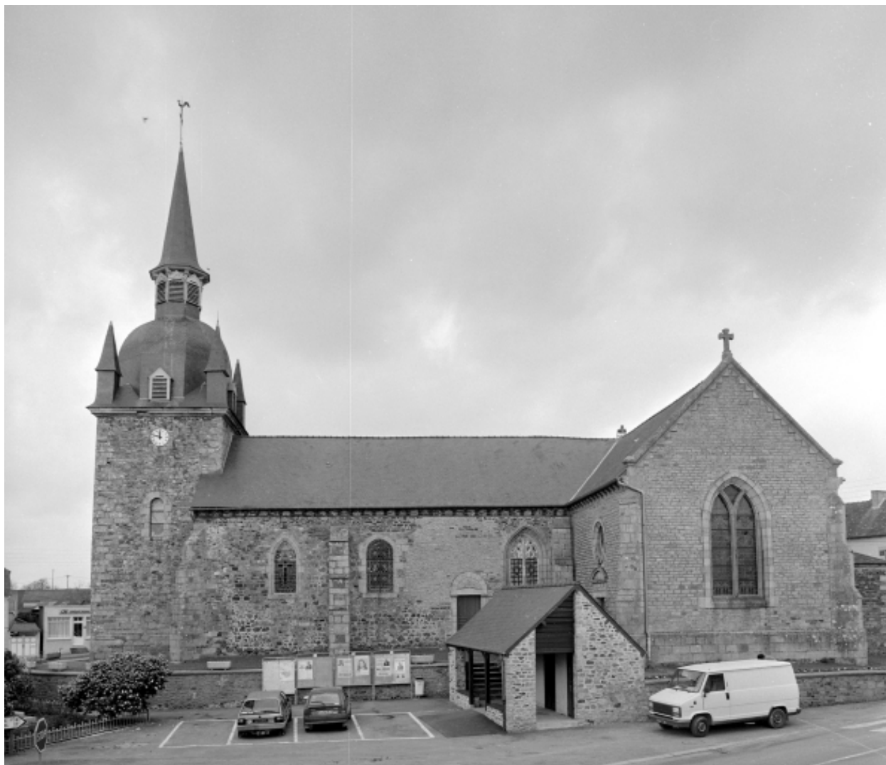
Elévation Sud : vue générale
