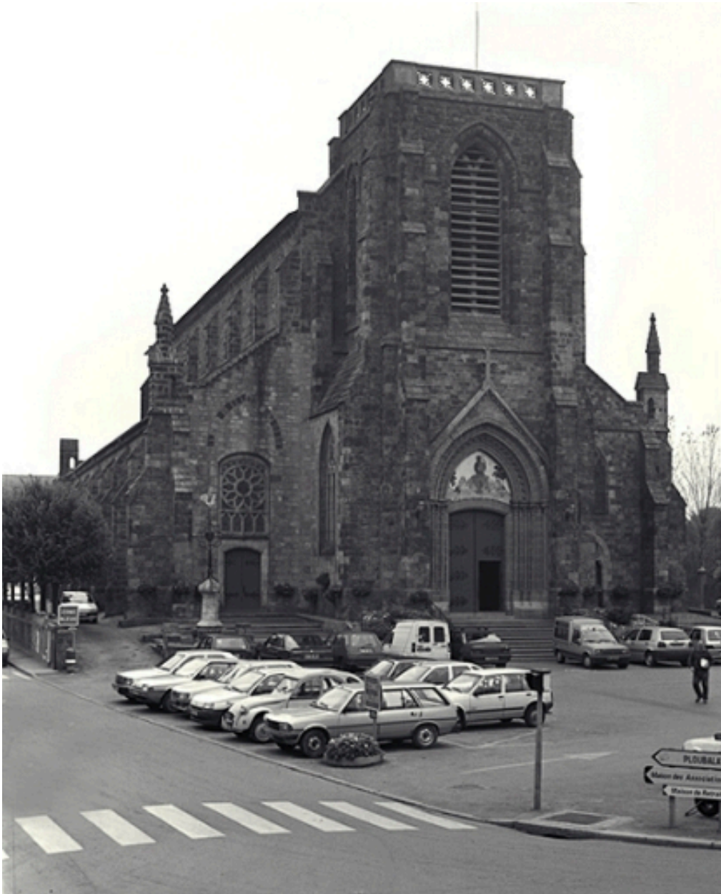
Elévation nord ouest : vue générale
