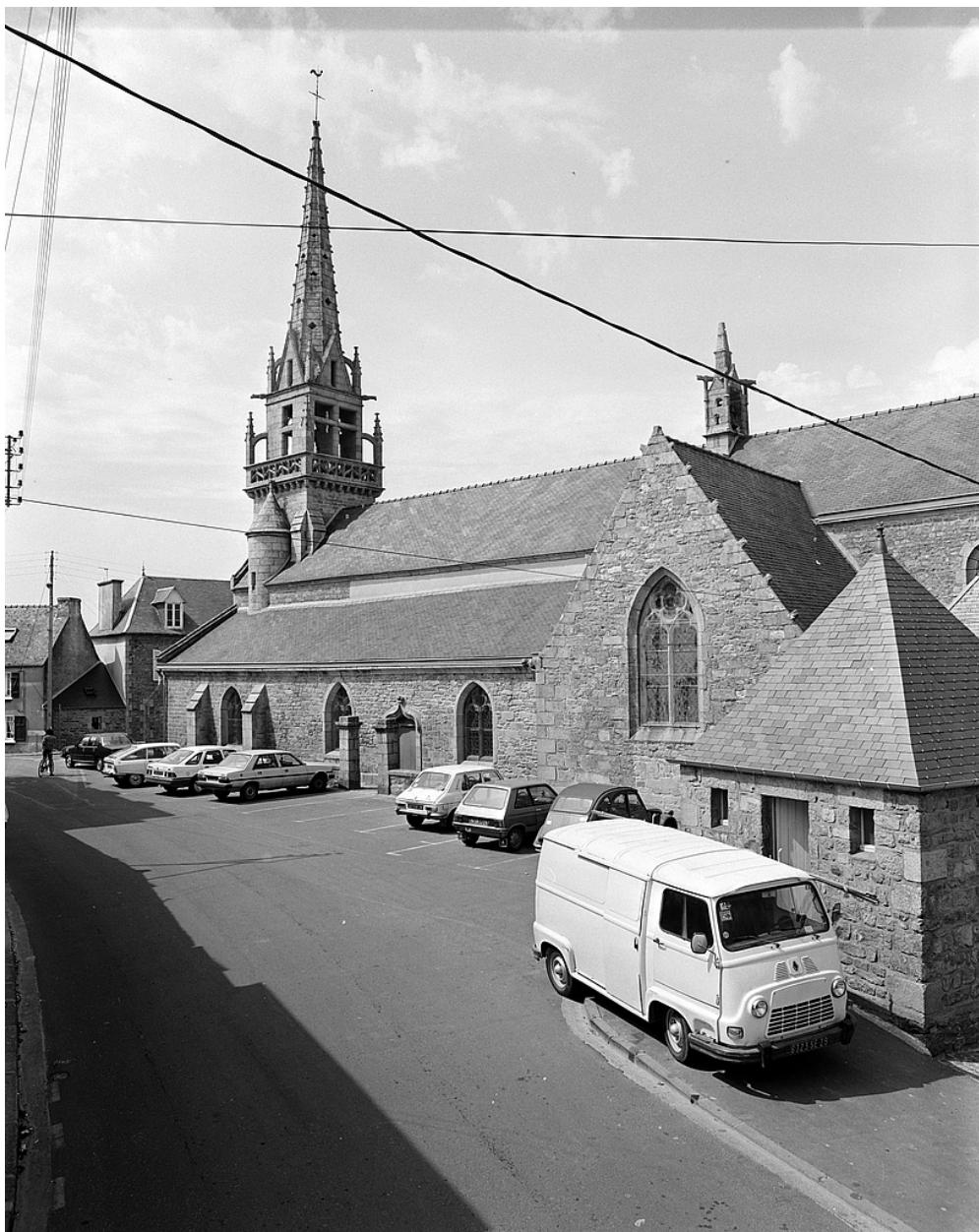
Vue générale du sud-est
