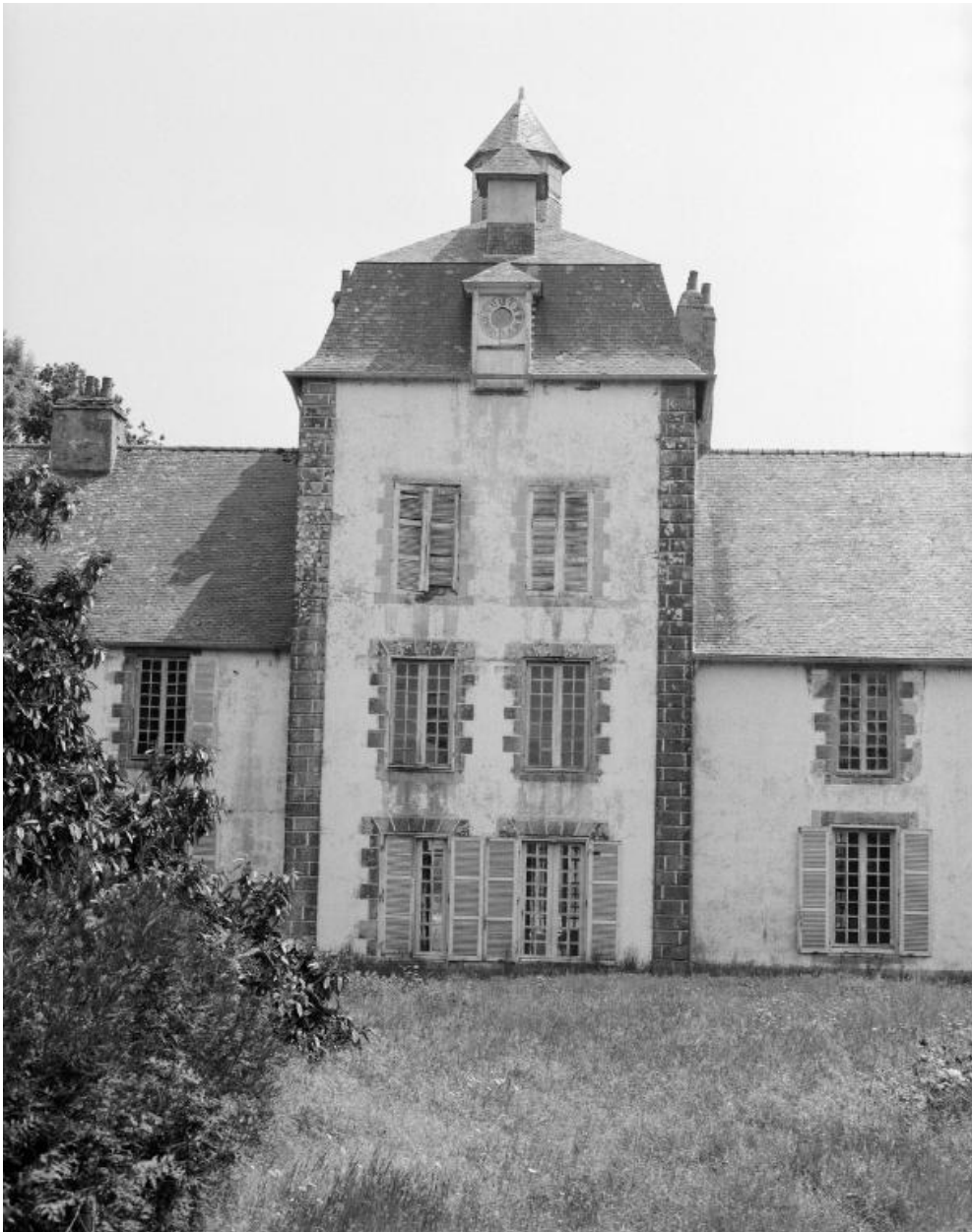
Elévation nord, pavillon central.
