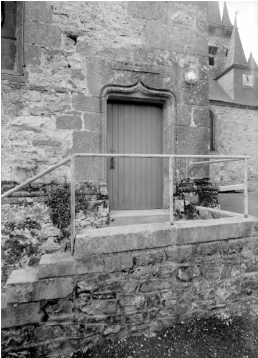
Elévation nord, transept, porte : vue générale
