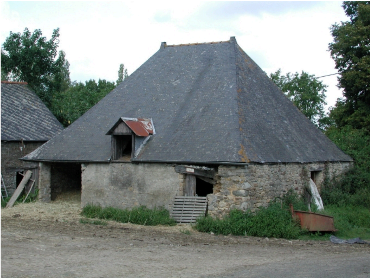
La ferme : anciennes écuries (?), vue générale sud-est
