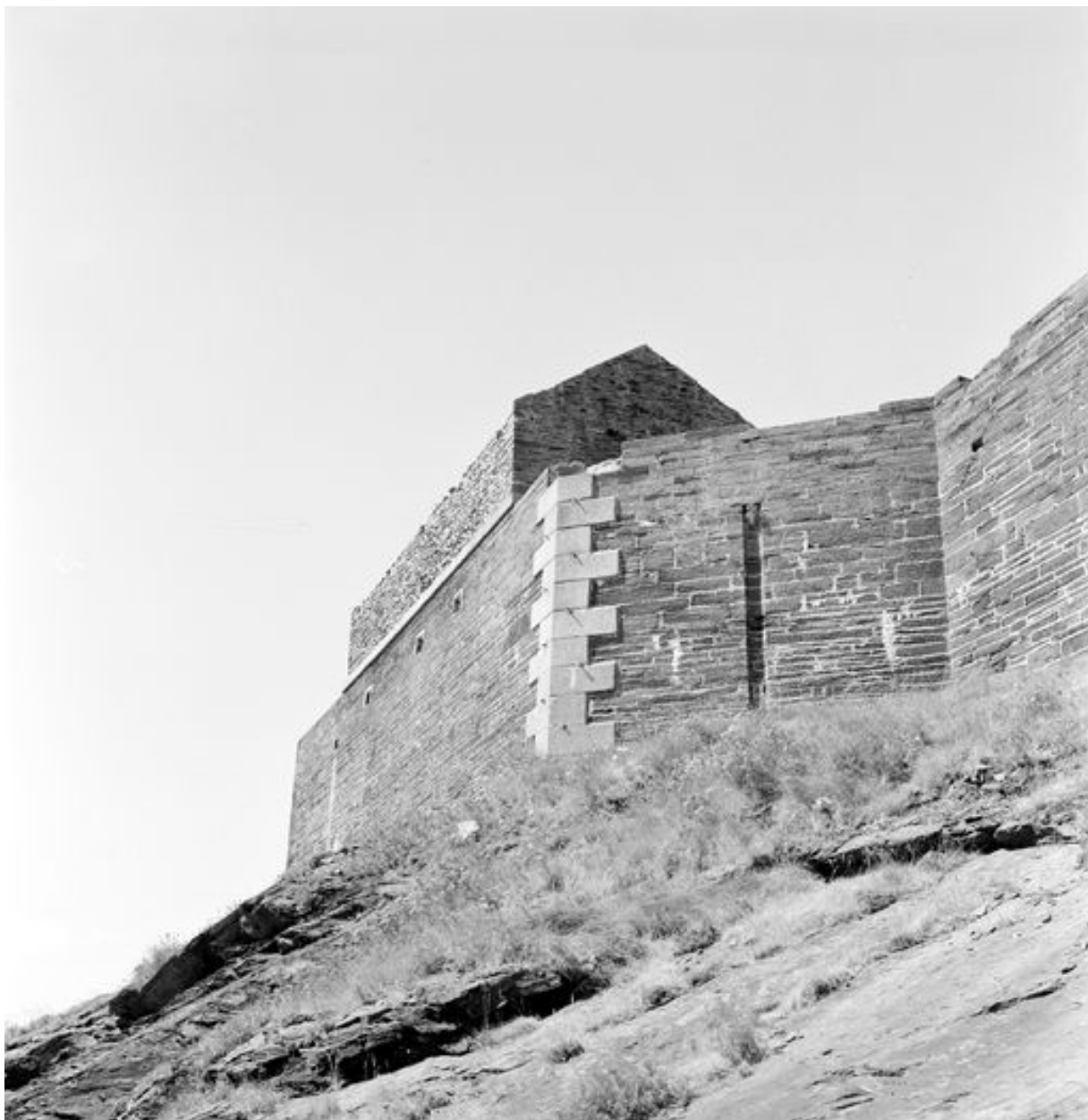
Vue de l'îlot des Capucins en 1969 : escarpe du front de gorge. A noter : les chaînes harpées d'angle en pierres de taille de granite
