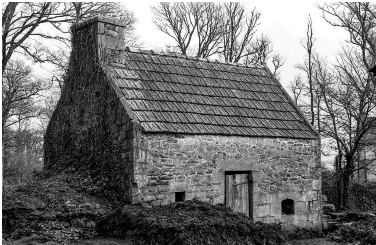
Fornil, élévation ouest et pignon nord avec cul-de-four. (1977)
