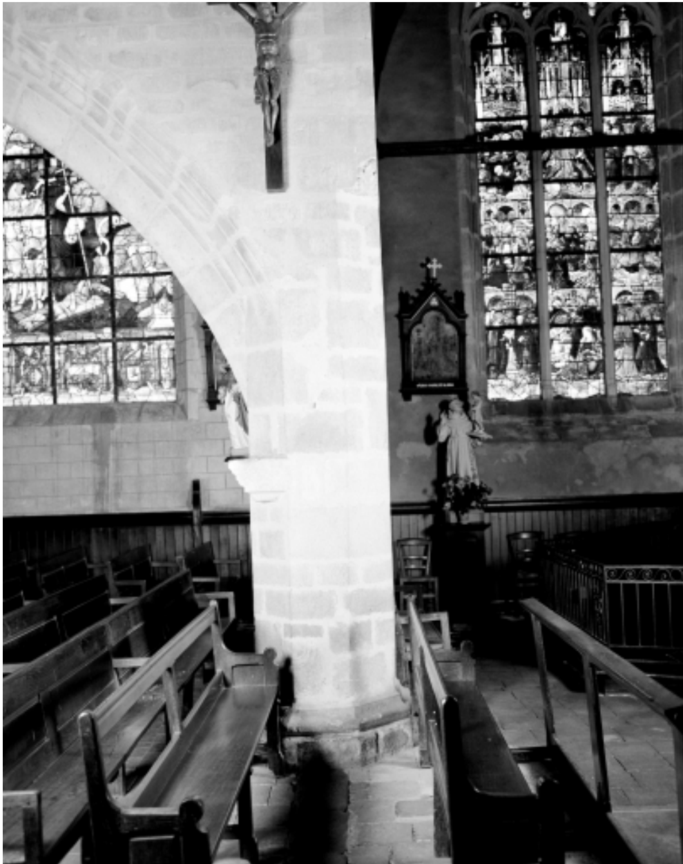
Vue générale intérieure.
