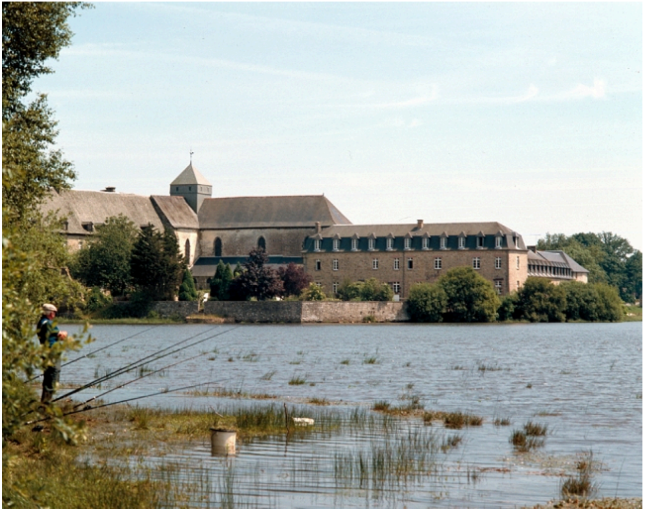
Vue partielle nord-ouest
