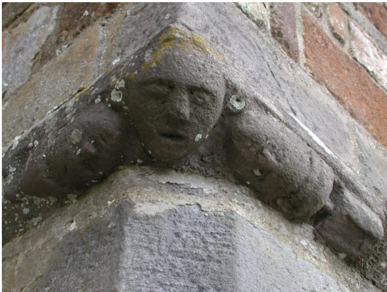
Elévation sud, porte ; détail
