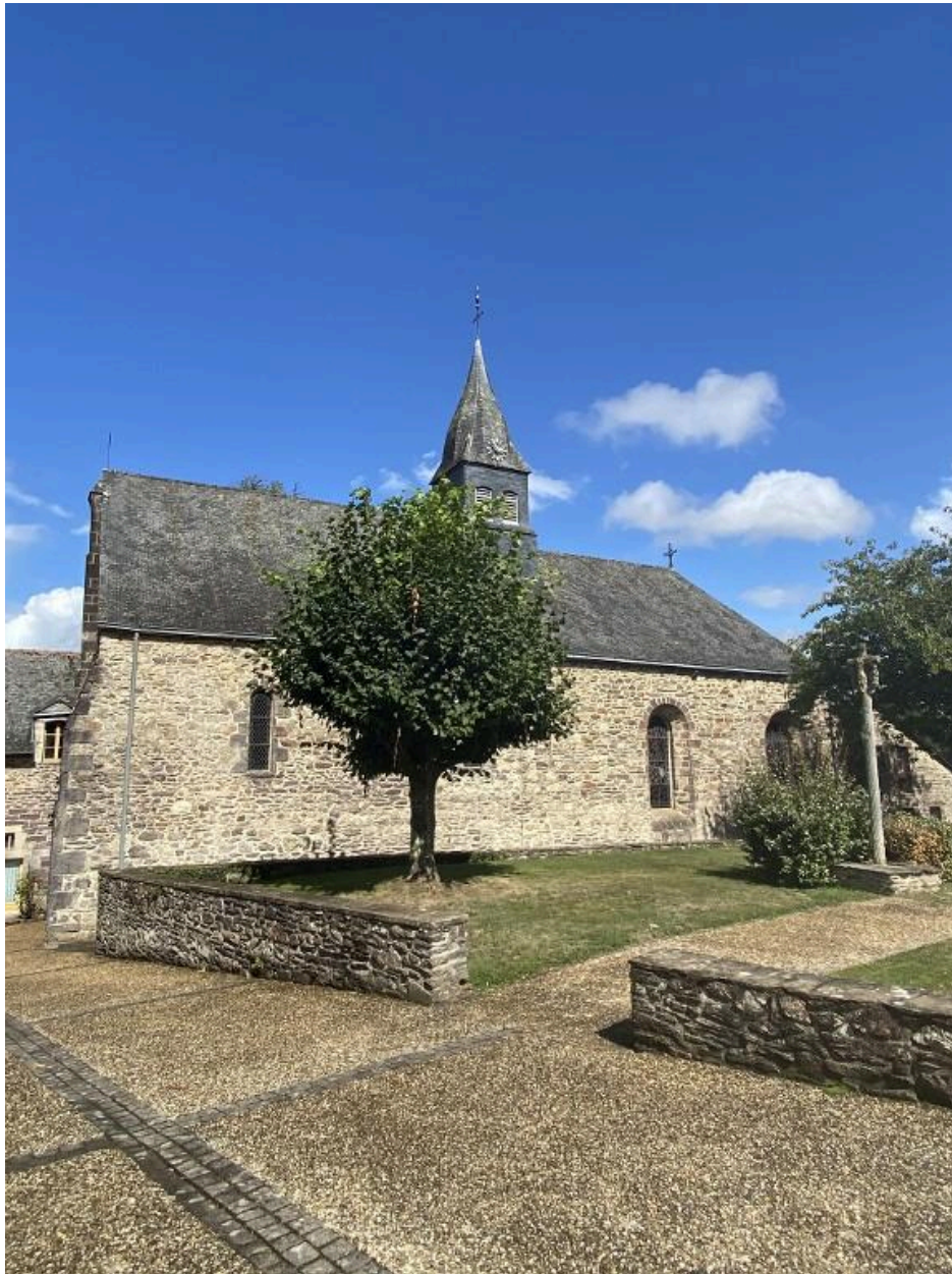
Vue générale sud
