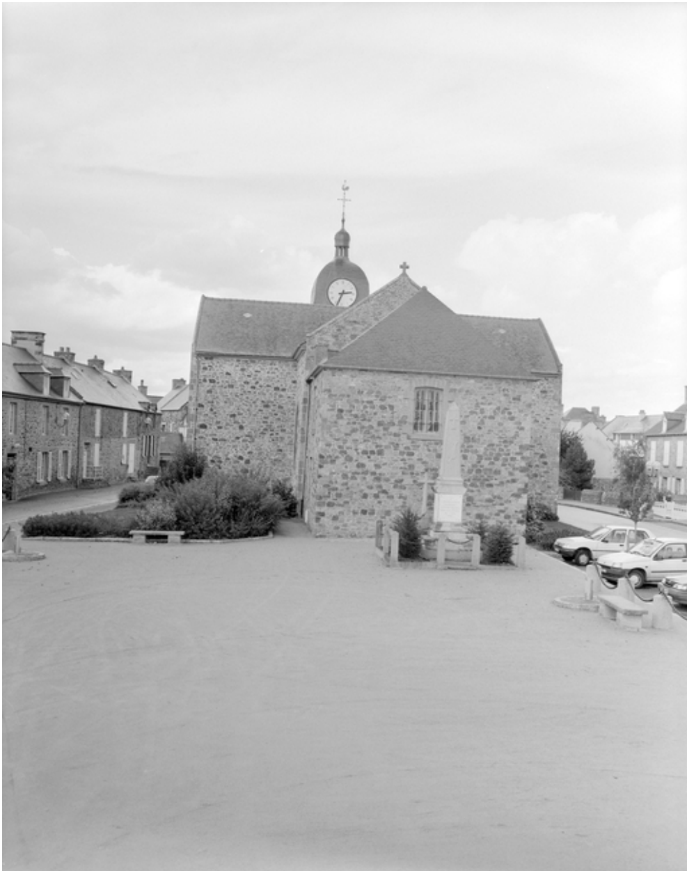
Elévation Est : vue générale.
