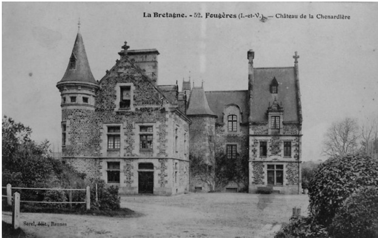
Vue générale sur l'arrière
