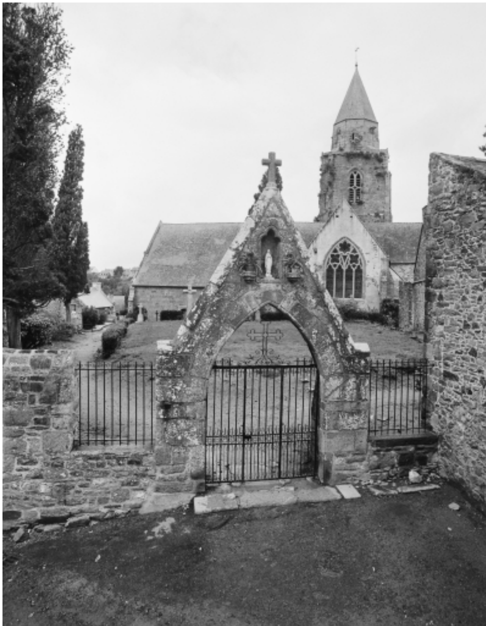
Elévation sud, portail : vue générale
