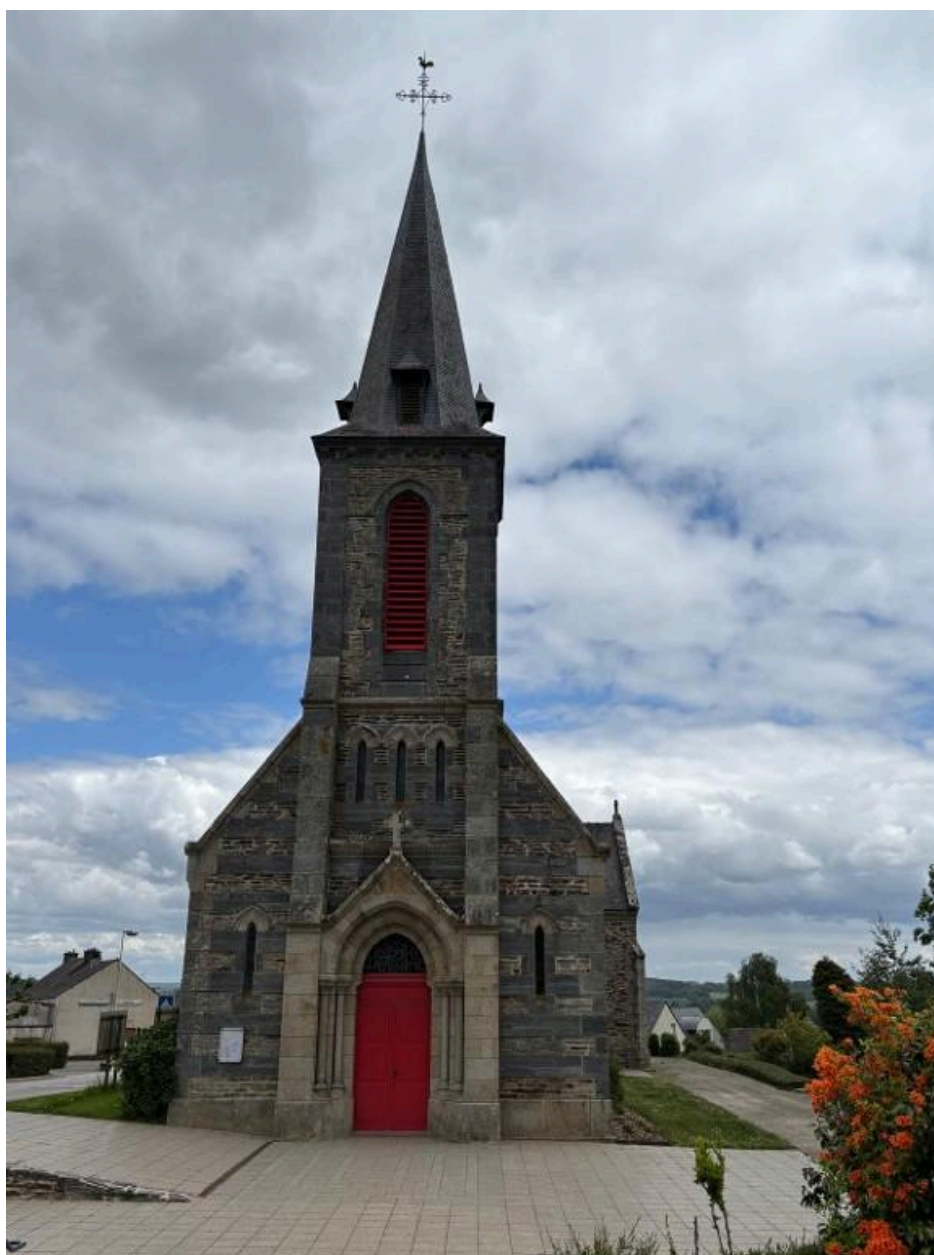
Vue ouest de l'édifice.
