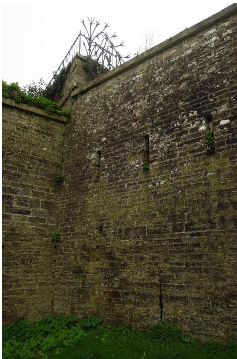
Le Palais, enceinte urbaine, bastion 20, flanc droit, mur crénelé flanquant la courtine 20-21.
