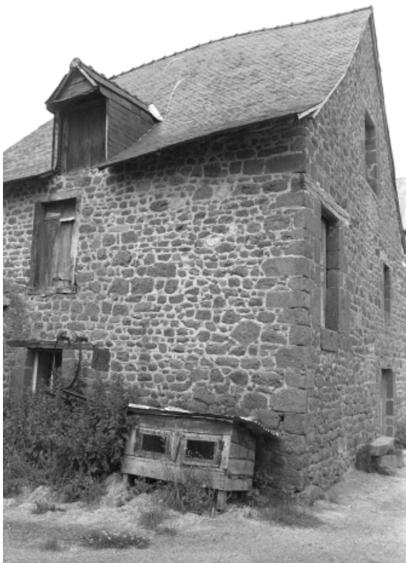
Ancien cellier du couvent
