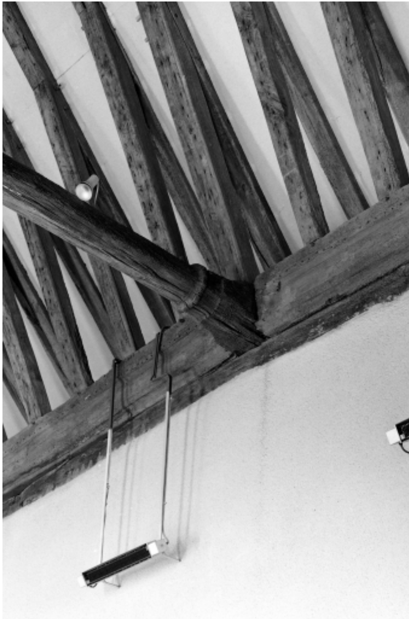
Intérieur, nef, charpente : détail de la sablière et de l'entrave.
