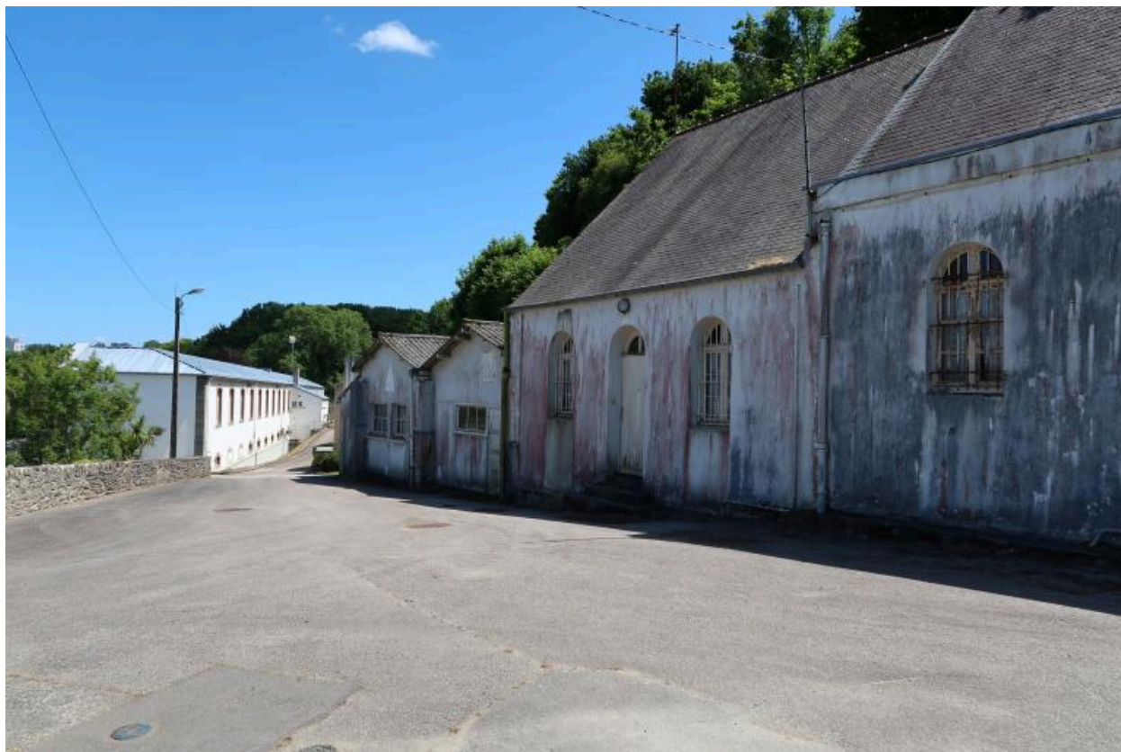
Vue générale : élévation nord de la prison et bâtiments accolés est (état en 2022)
