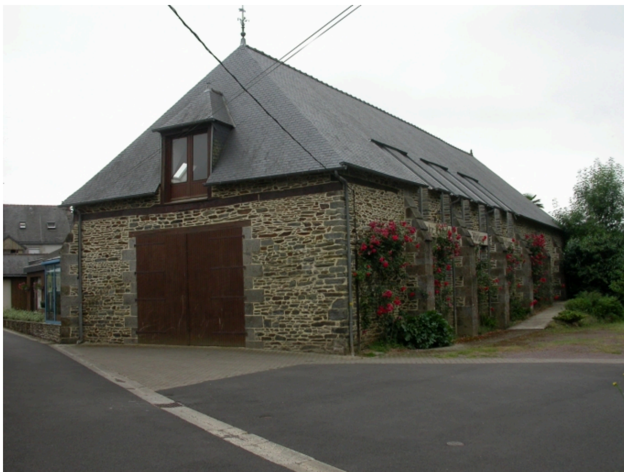
Vue générale de la halle de stockage de la tannerie.
