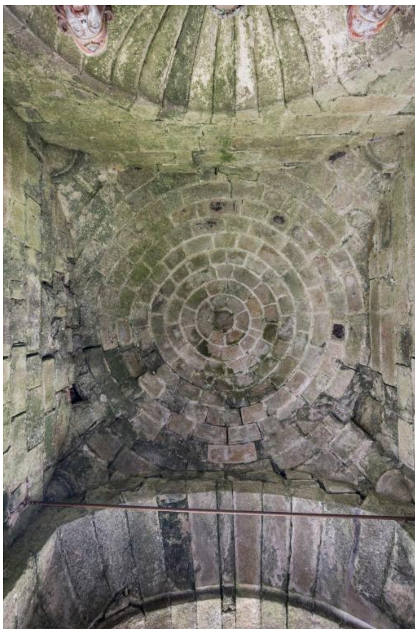
Vue de détail : coupole sur pendentifs de la scala sancta.
