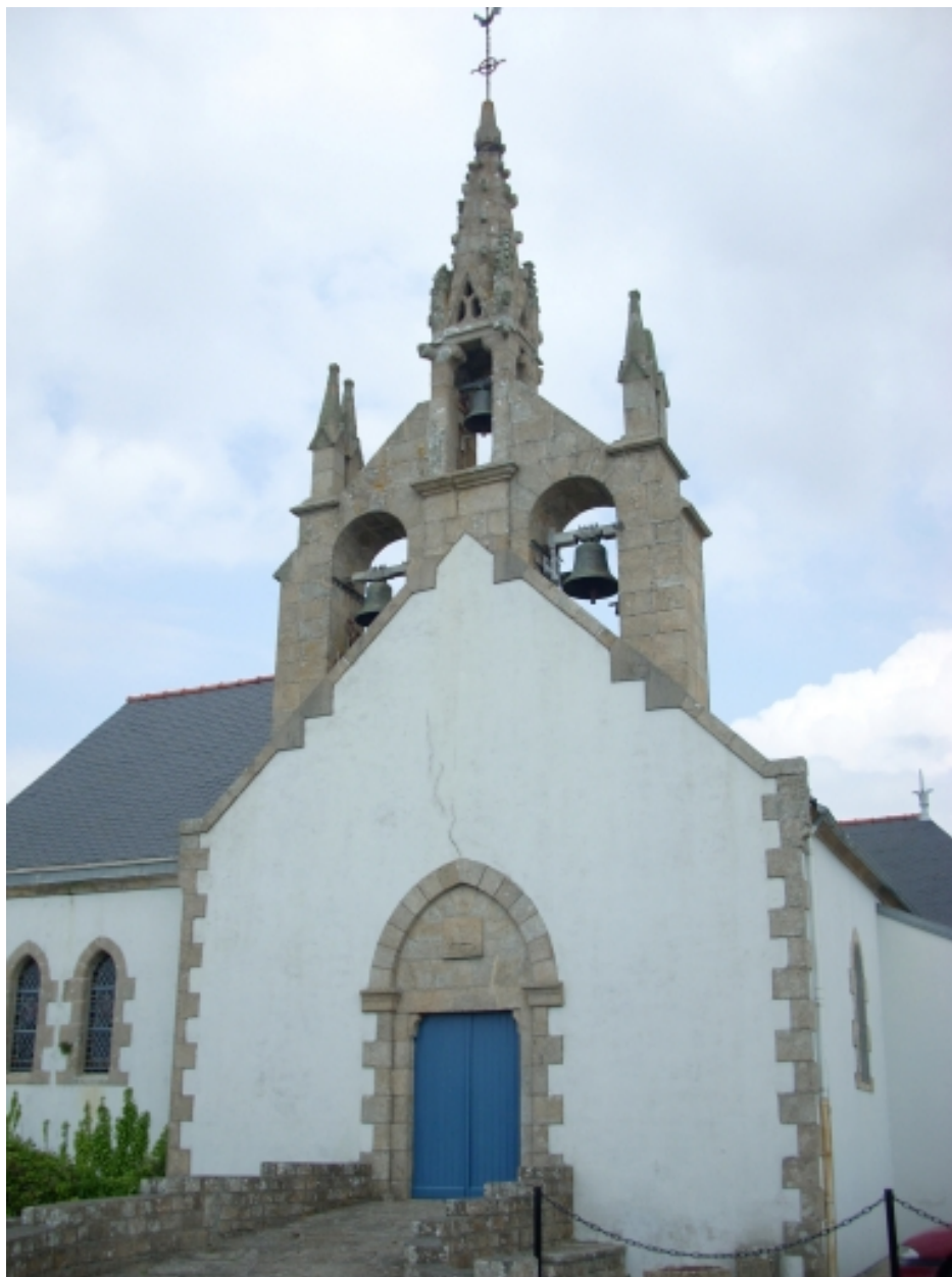
Plouhinec, église paroissiale de Poulgoazec : vue générale sud-ouest
