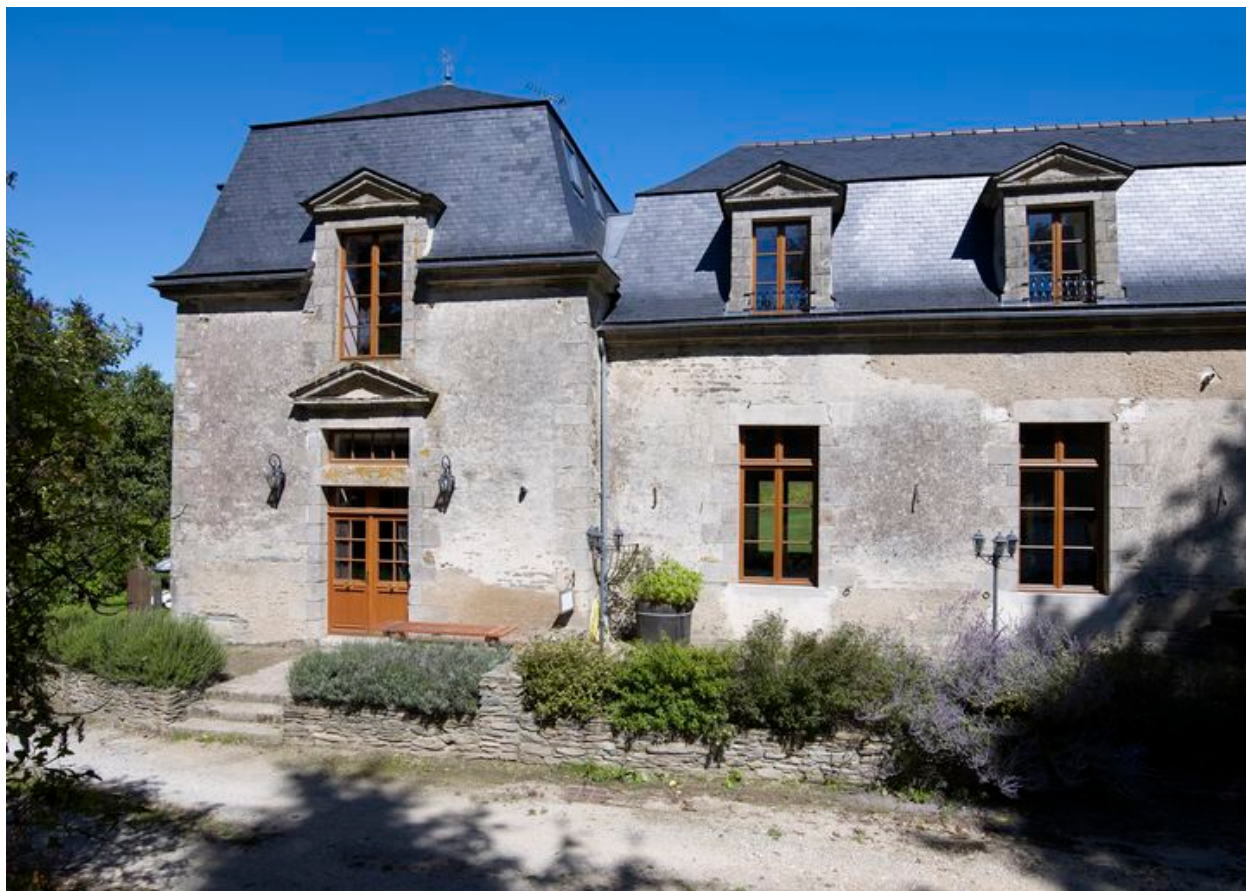
Château, dépendance est, élévation ouest : la partie nord (état en 2010)
