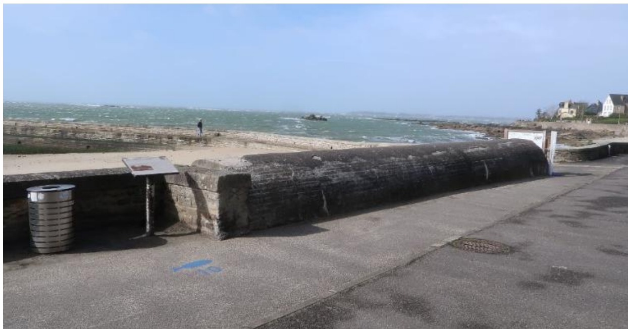
Le port de la Croix : matériaux différents pour protection
