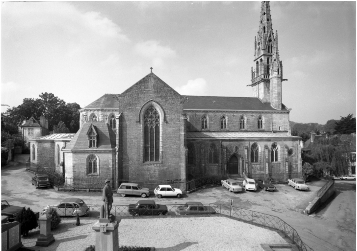
Châteaulin, église paroissiale Saint-Idunet : façade nord, vue générale, état en 1972
