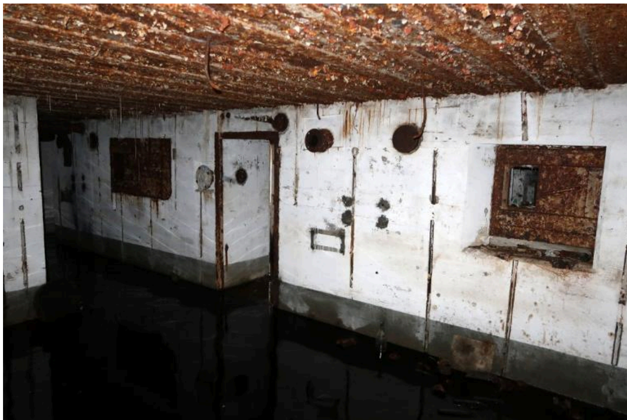
Vue intérieure : salle de garde sud. La porte débouche sur le sas. Au centre, emplacement du ventilateur [disparu] ; à droite, créneau blindé de défense
