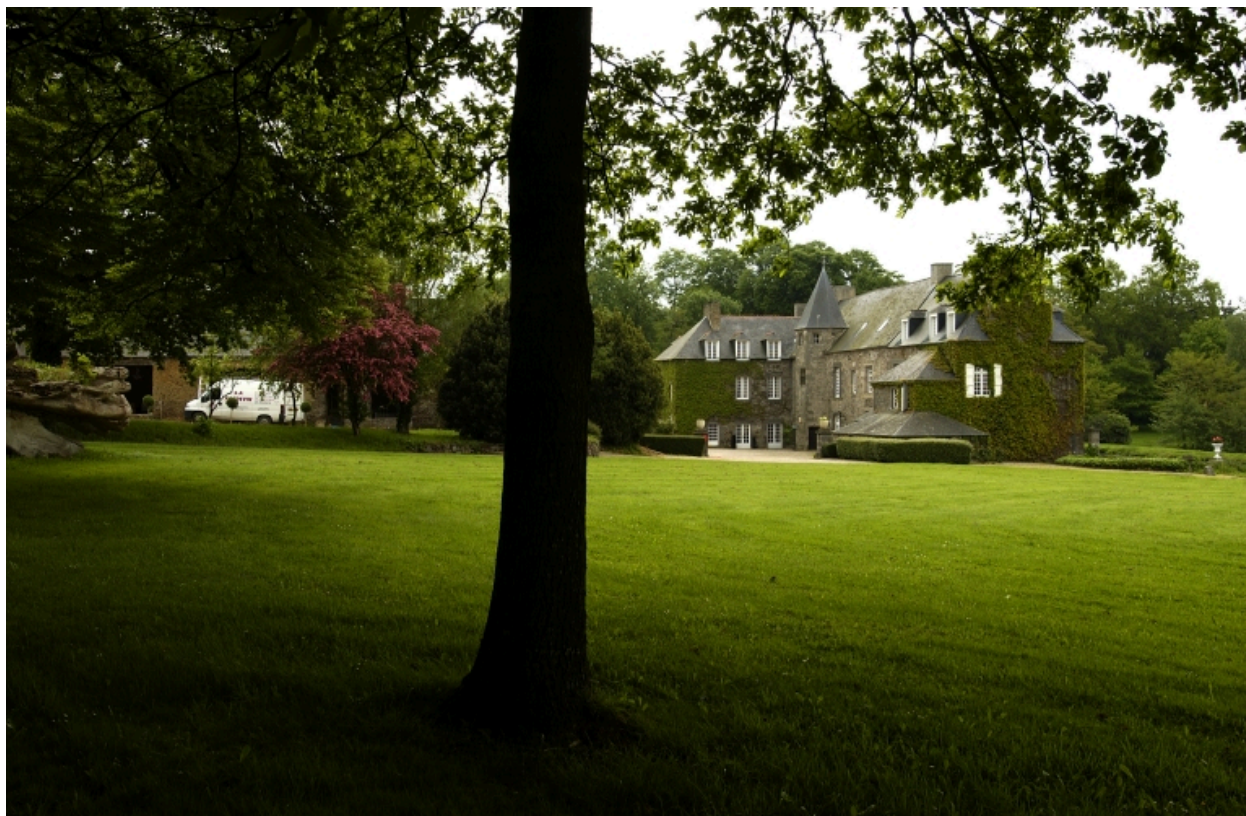
Vue générale nord ouest
