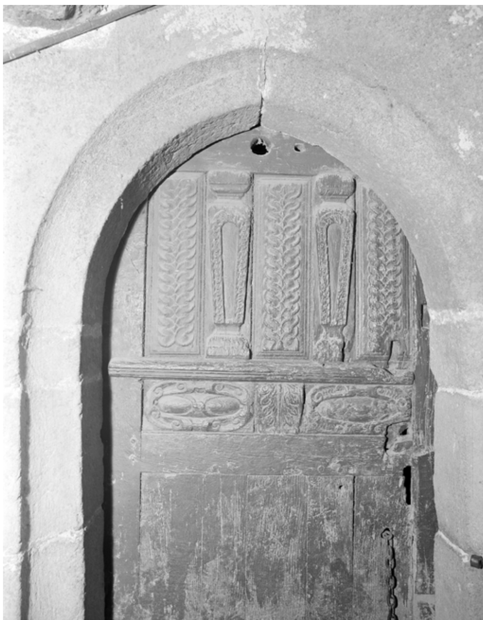
Détail de la porte de l'escalier
