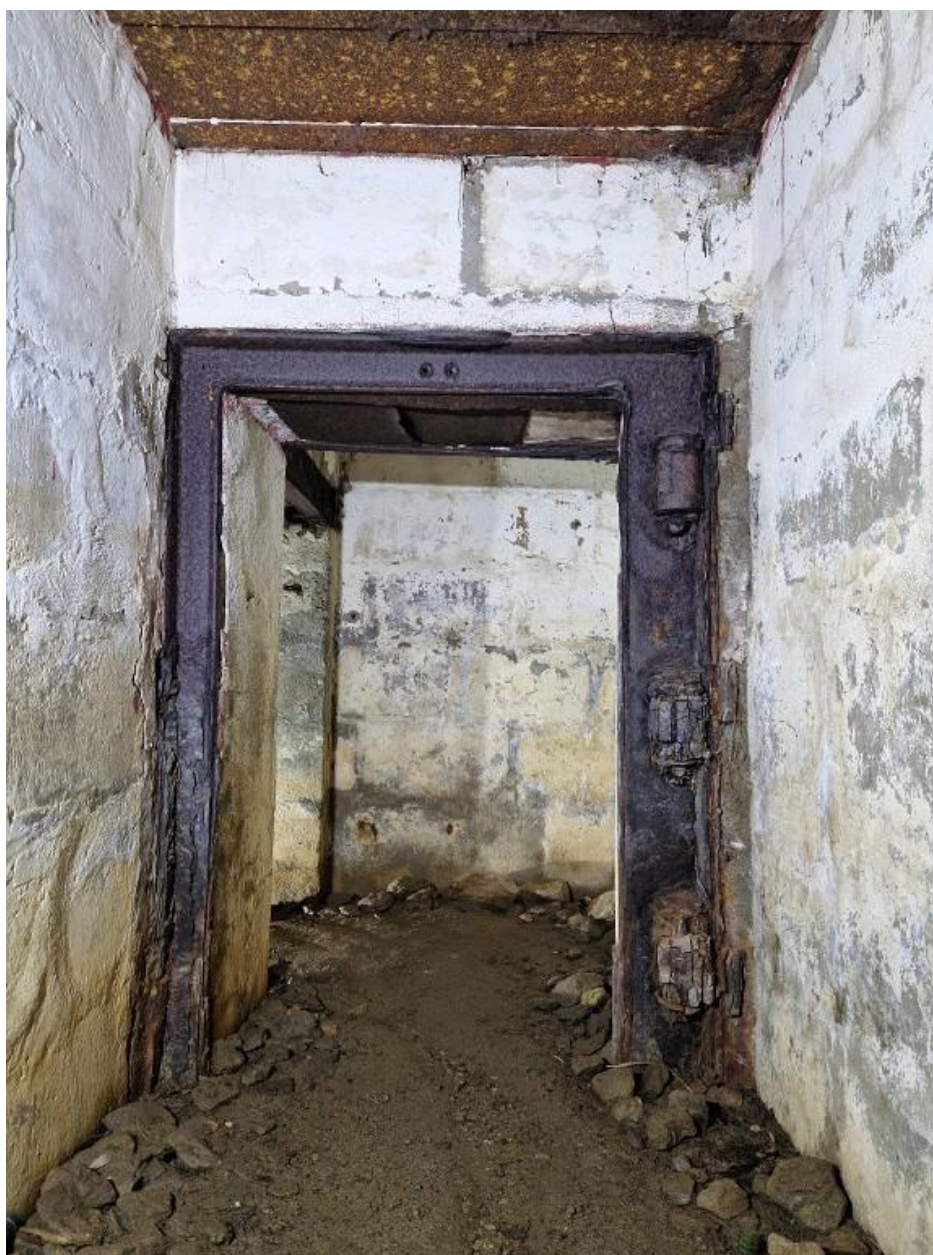
Vue intérieure : accès sud avec l'hubriserie de la porte blindée
