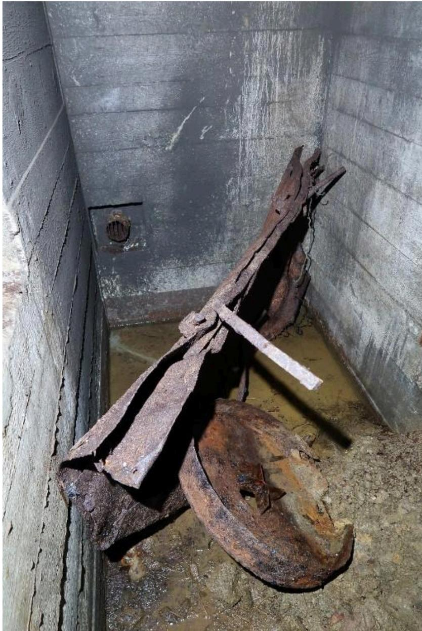
Vue de l'entrée nord : extrémité nord du couloir. Au sol, vestiges de la porte blindée légère des salles de garde et filtre à charbon du ventilateur
