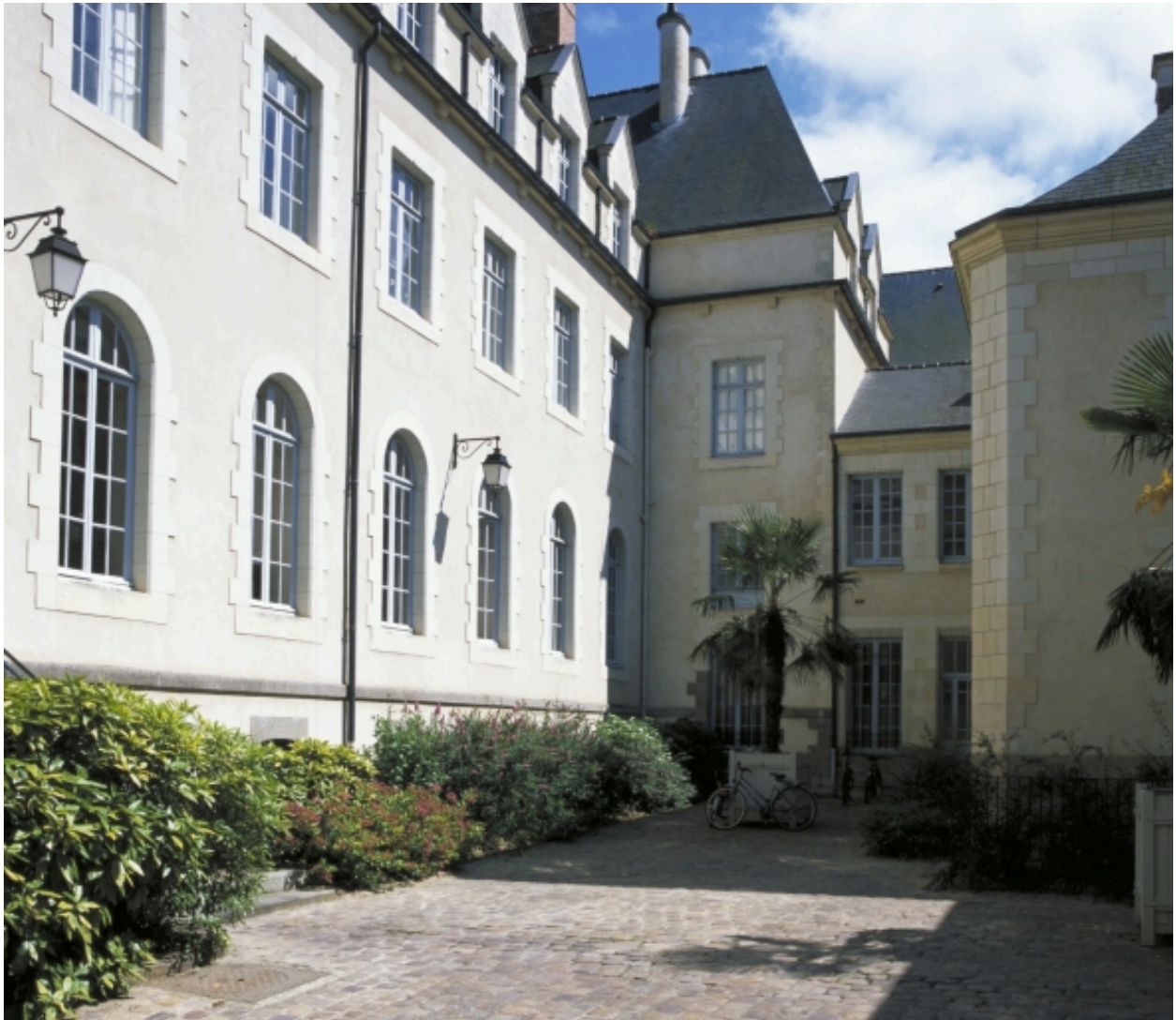
Vue sur cour intérieure
