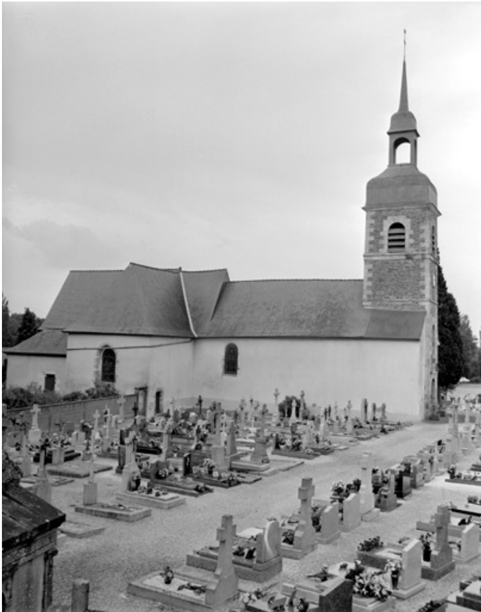
Élévation nord : vue générale
