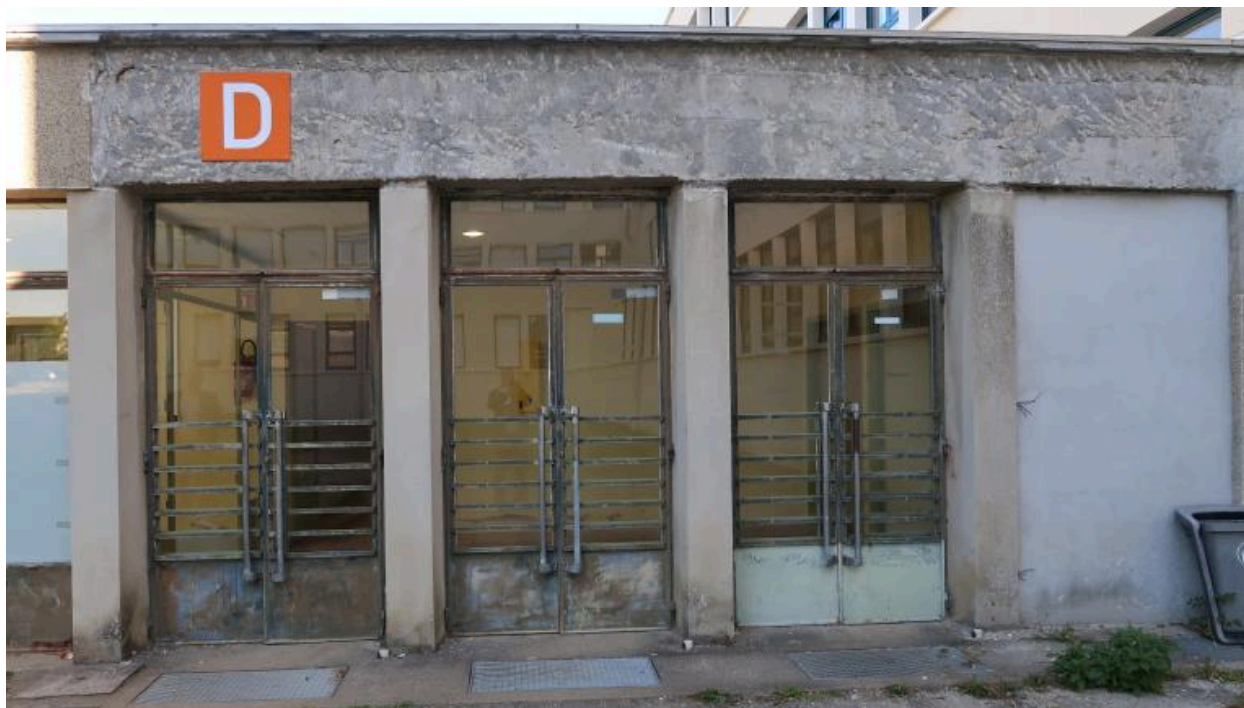
Portes d'entrée (bâtiment D). Menuiseries métalliques d'origine.
