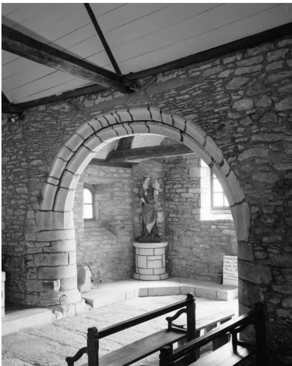
Arcade sud donnant sur le bras sud du transept
