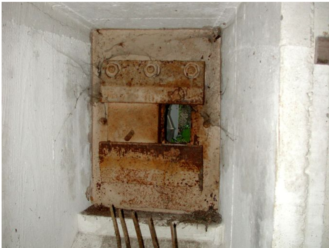
Vue intérieure : créneau blindé de défense d'entrée/sortie (état en 2003)
