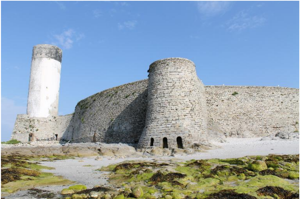
Façade sud-est du fort
